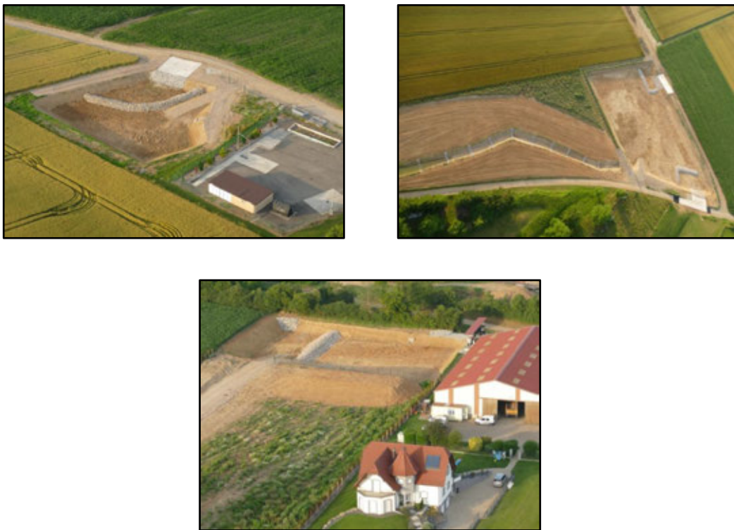
Figure 12 : Photos aériennes des ouvrages de rétention réalisés sur la commune de Geudertheim (SDEA)
