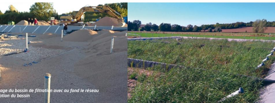
le garnissage du bassin de filtration avec au fond le réseau d'alimentation du bassin
