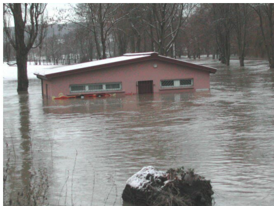
Le diagnostic de vulnérabilité au risque inondation est entièrement gratuit. Photo SDEA - Le diagnostic de vulnérabilité au risque inondation est entièrement gratuit. Photo SDEA
