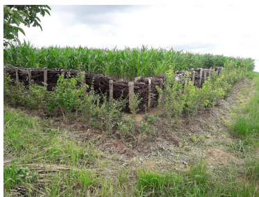
Dans le Bas-Rhin, le SDEA réalise depuis 2015 des aménagements végétaux, comme ces fascines, pour freiner le ruissellement de l'eau et les coulées d'eau boueuse. Photo SDEA
