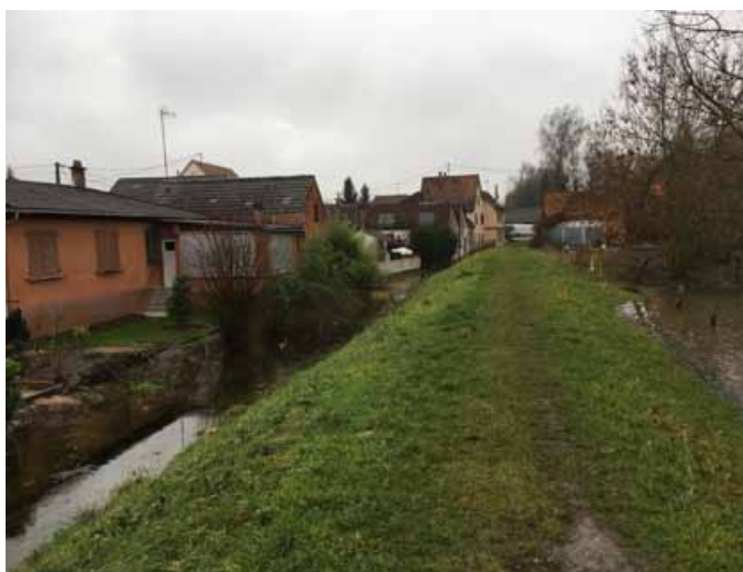
La digue qui protège le village.
