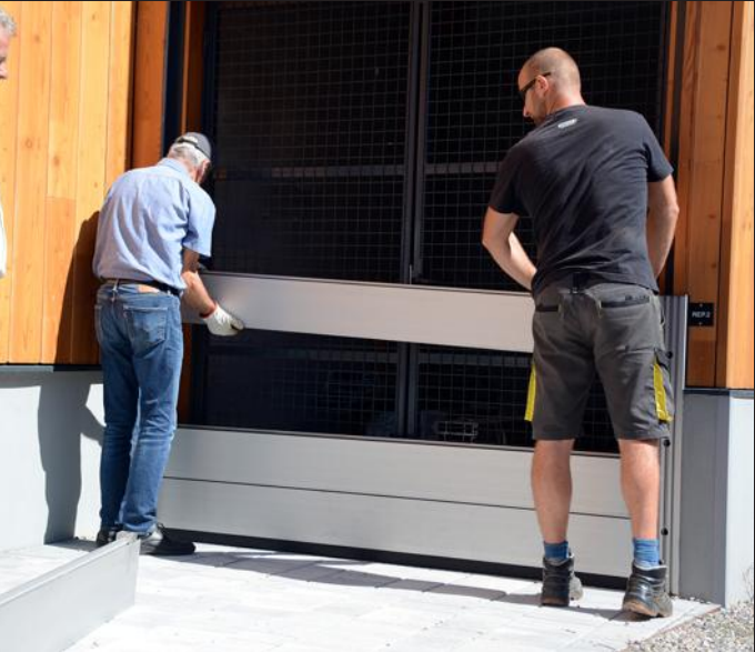
Exercice de mise en place des batardeaux sur le nouveau gymnase à Muttersholtz. Photo DNA
