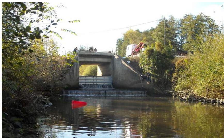
Figure 34 : La Vanne Lerchenberg (Amont Haguenau)
