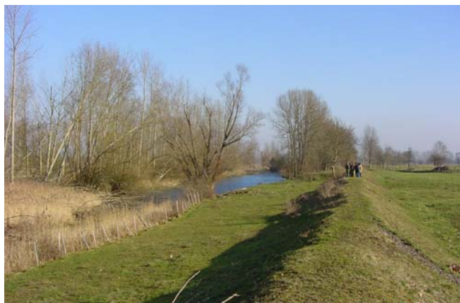
Figure 53 : Une digue de la Moder aval
