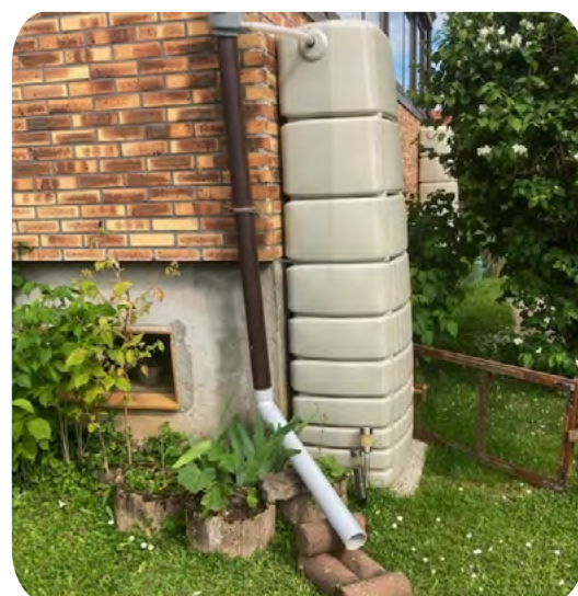
COLLECTEUR ET DISPOSITIF DE FILTRATION
